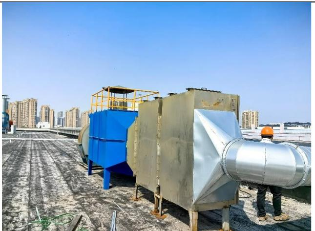
注塑、塑料挤出、热成型废气治理装置
