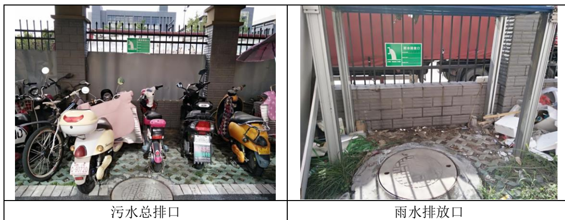
图 3-2 污水、雨水排放口照片
